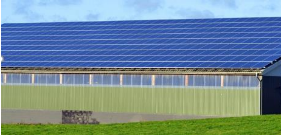
Příklad velké střešní instalace - Zdroj: Fotolia.com - Sinuswelle
